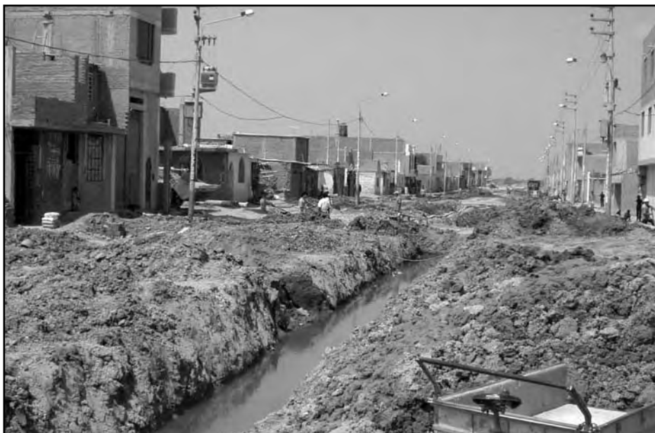
Construcción de calles, veredas y alamedas
