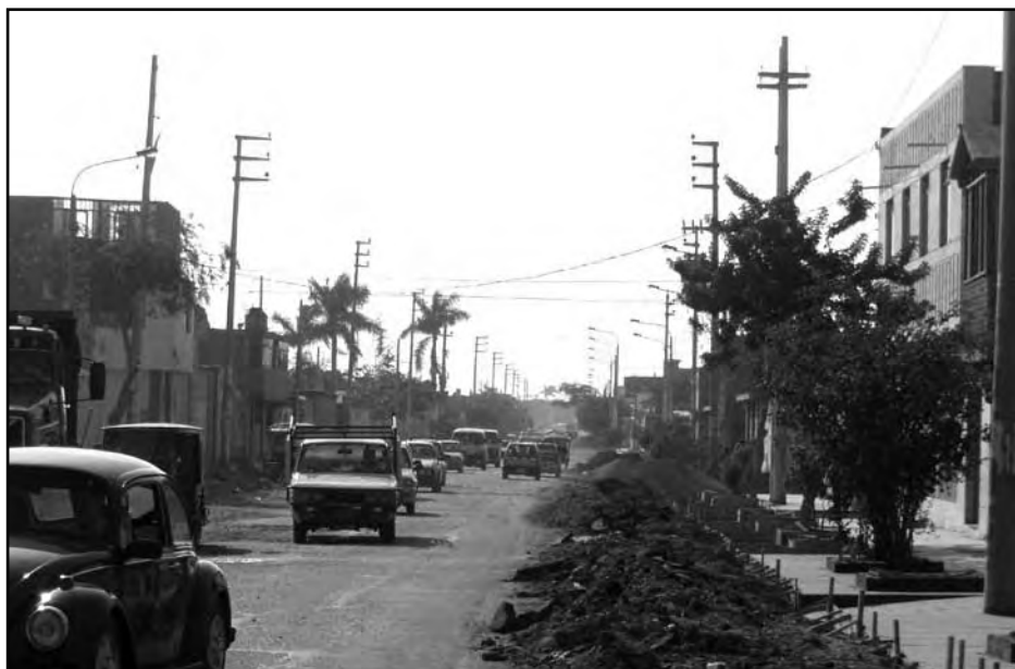
Construcción de calles, veredas y alamedas
