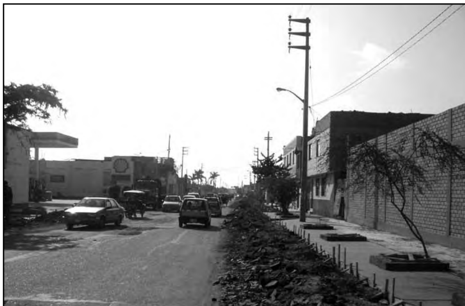
Construcción de calles, veredas y alamedas
