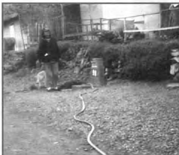
La pileta cumple con la función de acercar el agua segura a las casas.
