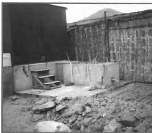
El Módulo Sanitario Productivo ha respondido a una cotidiana necesidad de disponer adecuadamente las excretas en casa.
