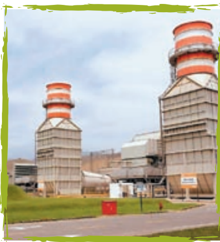
Figura N°35. Central termoelectrónica de Ventanilla.
