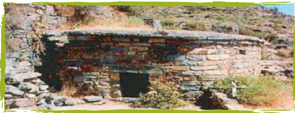
Figura N° 67: Una de las estructuras mejor conservadas en Cantamarca.
